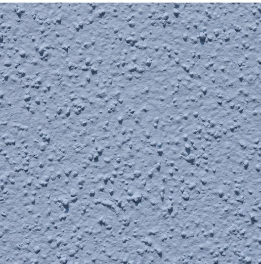
Nicht nur ein optisches Highlight: Hochwertige Außenputze und -farben schützen Wände vor eindringendem Wasser und verhindern dadurch, dass Kohlendioxid und Salze die Materialstrukturen des Betons angreifen.
